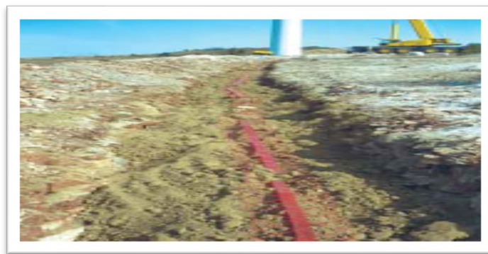
Фиг. I.3.7.-1 Полагане на кабелните връзки
