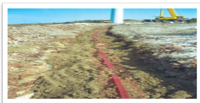
Фиг. 2.3.7.-1 Полагане на кабелните връзки
